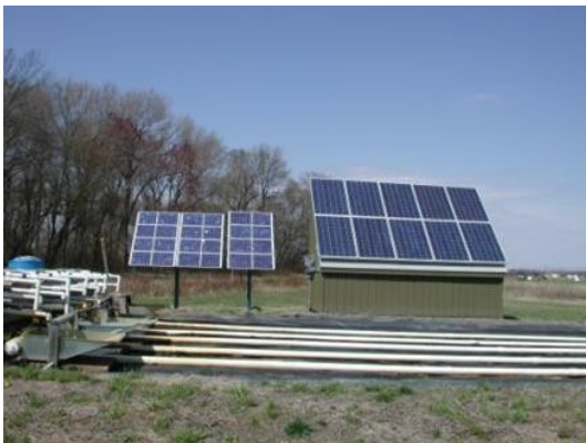
Figur 2. Til venstre ses solcellerne der driver pumpen til cirkulation af drænvandet ovenpå gummipladerne (billede højre) (Kangas & Mulbry, 2014b).
